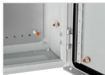
Шпильки заземления, вводная панель на дне.
